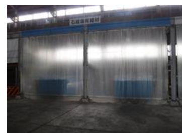
本社倉庫内の保管施設状
